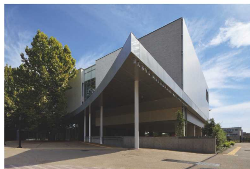
都立多摩図書館外観
